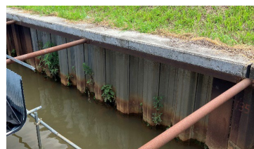
図5 更新護岸(設置後5年)
