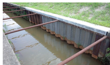
図4 更新護岸(設置後1年)
