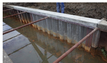
図3 更新護岸(設置直後)
