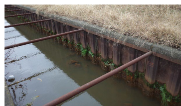
図2 既設護岸(設置後40年)
